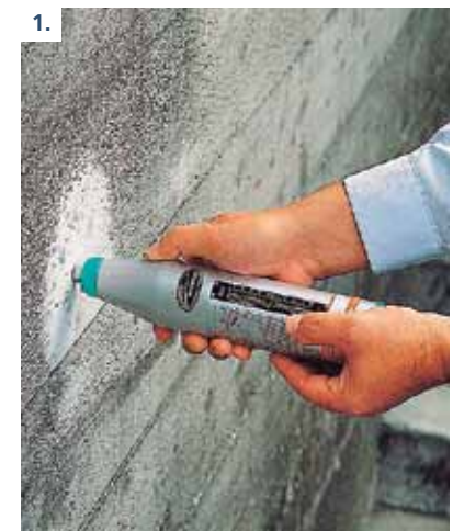
1. Una de las pruebas para estimar rápidamente la calidad del concreto es mediante el uso del Martillo de Rebote o Esclerómetro.
