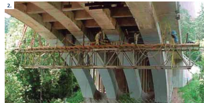
1. El colapso del Puente Loncomilla en Chile (2004). 2. Reforzamiento FRP de las vigas de un puente con mantas de fibra de carbono (Cortesía de FYFE LA).
