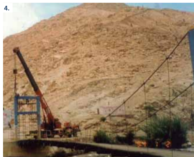
3 y 4. Desde el año 2000 en el Perú se viene reforzando puentes con fibra de carbono. En la foto: reforzamiento con FRP del puente colgante Chasquitambo, ubicado en Ancash (Cortesía de Constructora RF SAC.).
