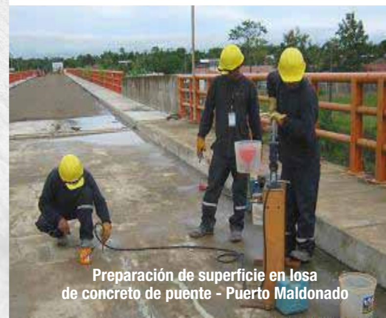
Amolado de superficie para identificación de Fisura a reparar
