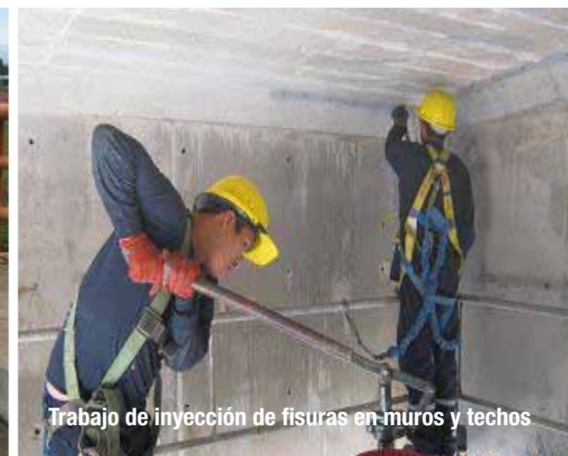
Perforación de orificios para colocación de puertos de inyección (packers)
