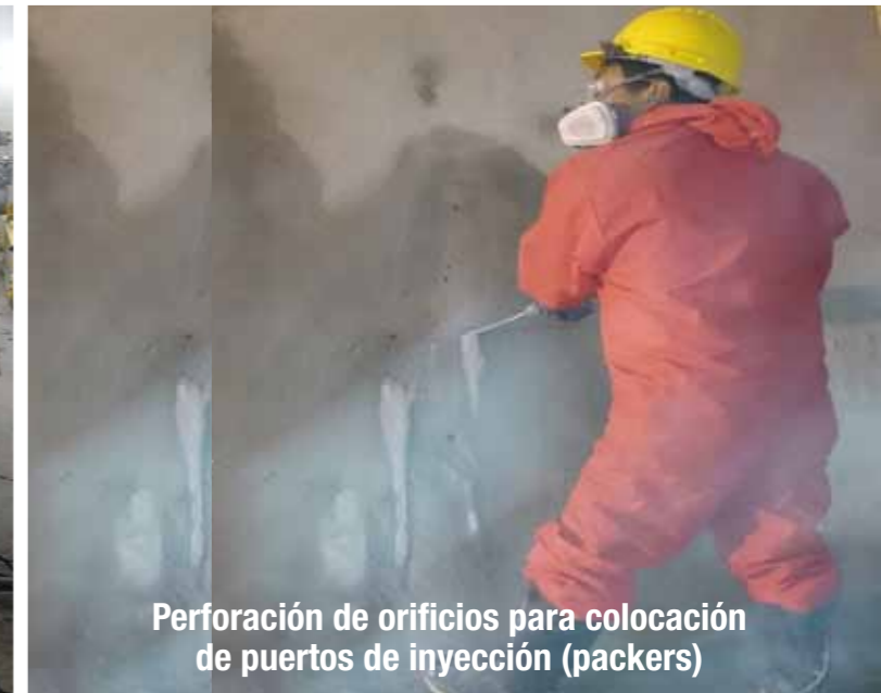
Colocación de puertos de inyección (packers)
