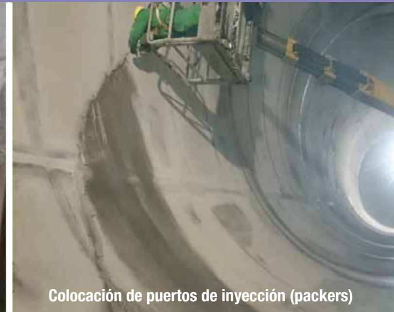
Inyección de Resina de Poliuretano con Bomba de Pistón de Alta presión ( P_{\text{máx}} = 5000 \text{ psi} )
