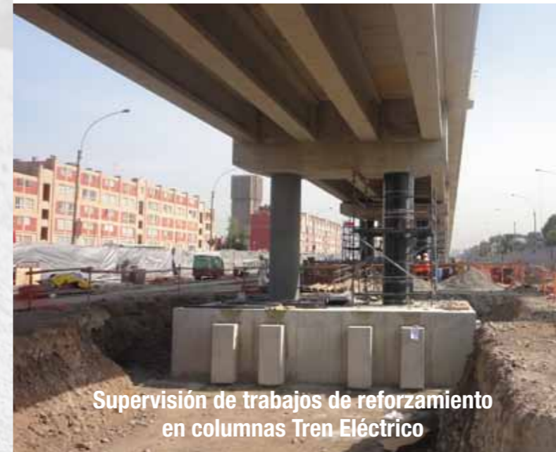
Preparación de Monocolumnas - Tren Eléctrico
