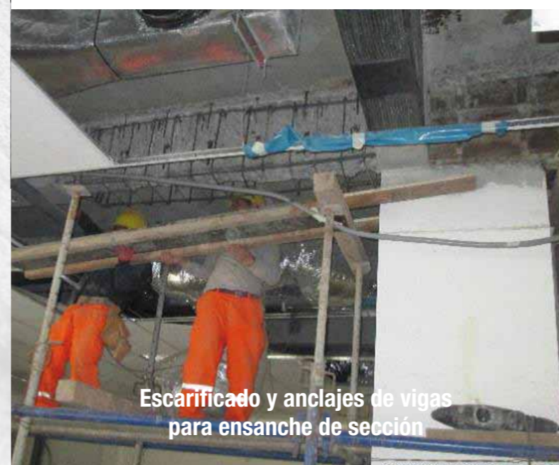
Ensanche de sección y estriado adicional en vigas
